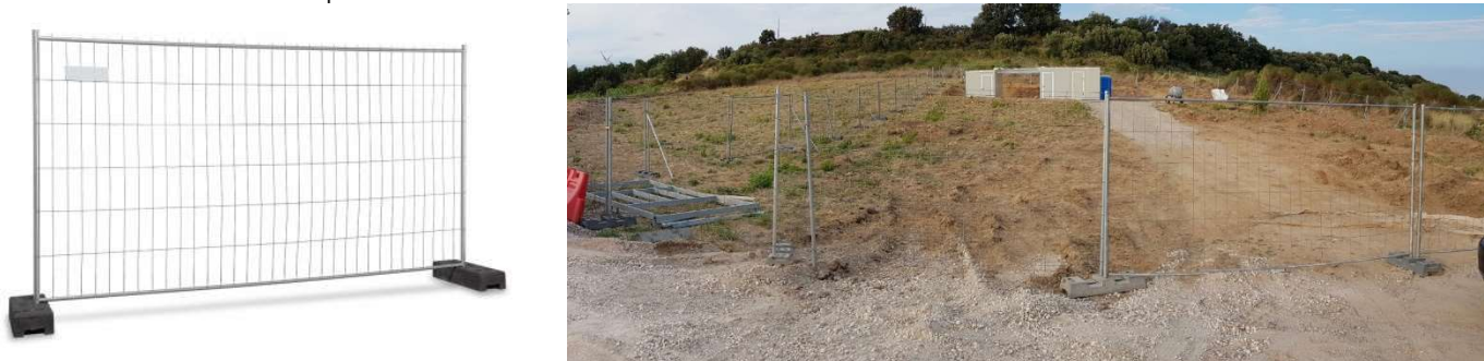
■ Figures 4 : Exemple de clôture mobile pour le balisage de l'aire de chantier
